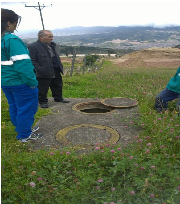
Ilustración 9 – Cámara de quiebre y estación reductora de presión
