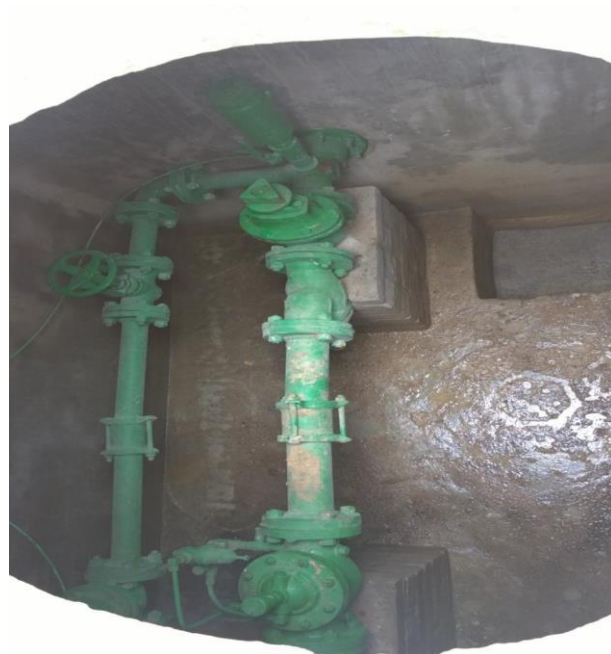
Ilustración 9 – Cámara de quiebre y estación reductora de presión
