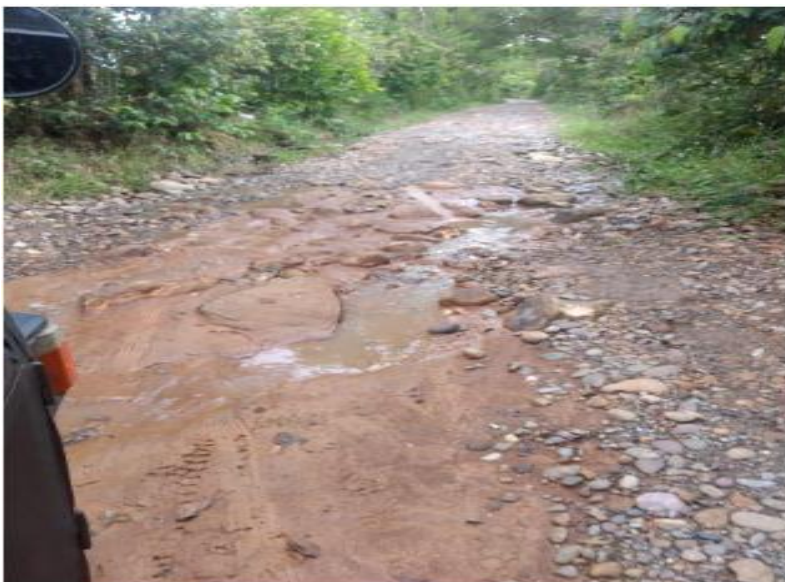
Figura 15: Vía de Acceso al Aeropuerto
