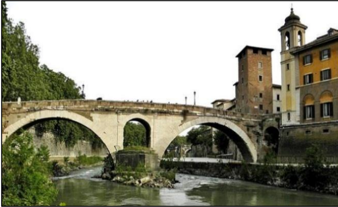
Figura 3. Puente Fabricio actualizado
