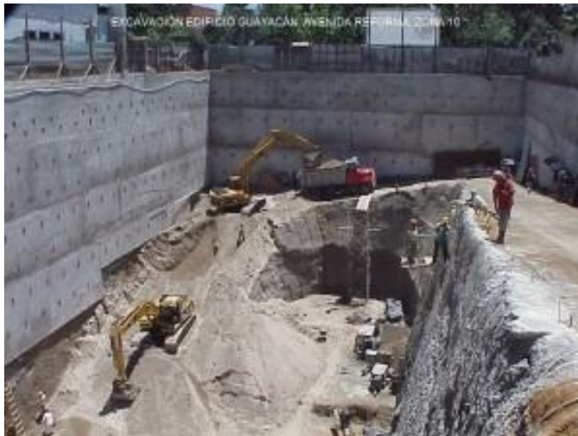
Imagen N° 3 Excavación y retiro de materiales
