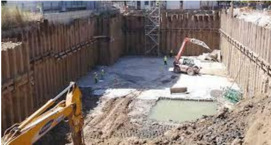
Imagen N° 2 Estabilización con Table-estacado
