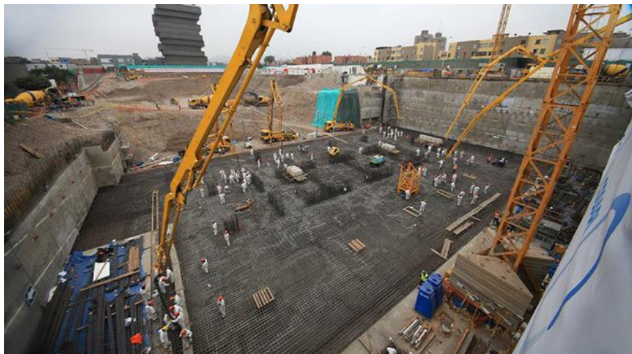
Imagen N° 5 Proceso constructivo de placa de cimentación
