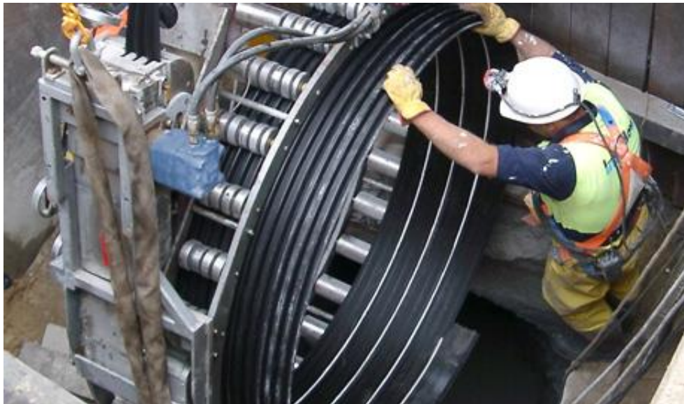
Fotografía 3. Enrollado helicoidal SPR
