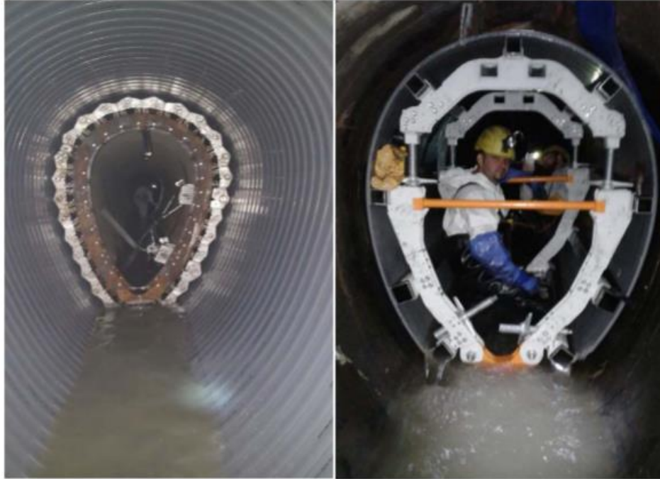
Fotografía 4. Vista de perfil helicoidal instalado
