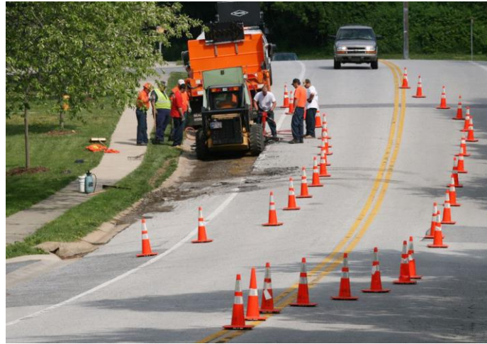
Fotografía 5. Señalización vial temporal de obra
