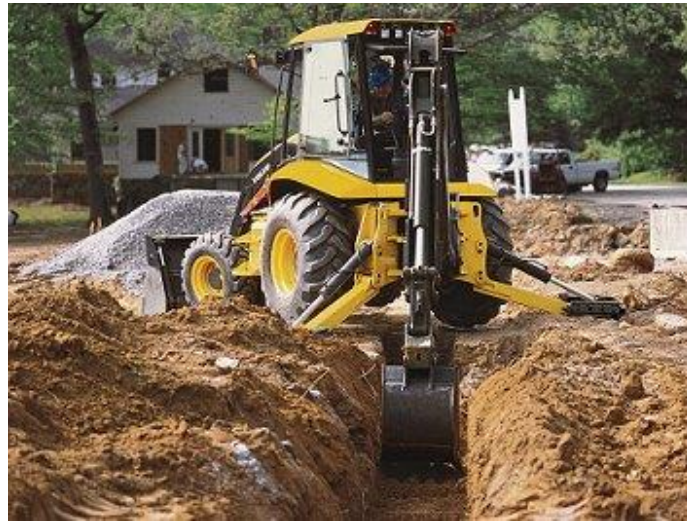
Fotografía 6. Excavación mecánica para redes
