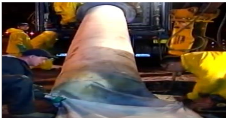
Fotografía 2. Proceso reversado del liner impregnado Fuente: https://www.youtube.com/watch?v=8Ggpz5oQmDM
