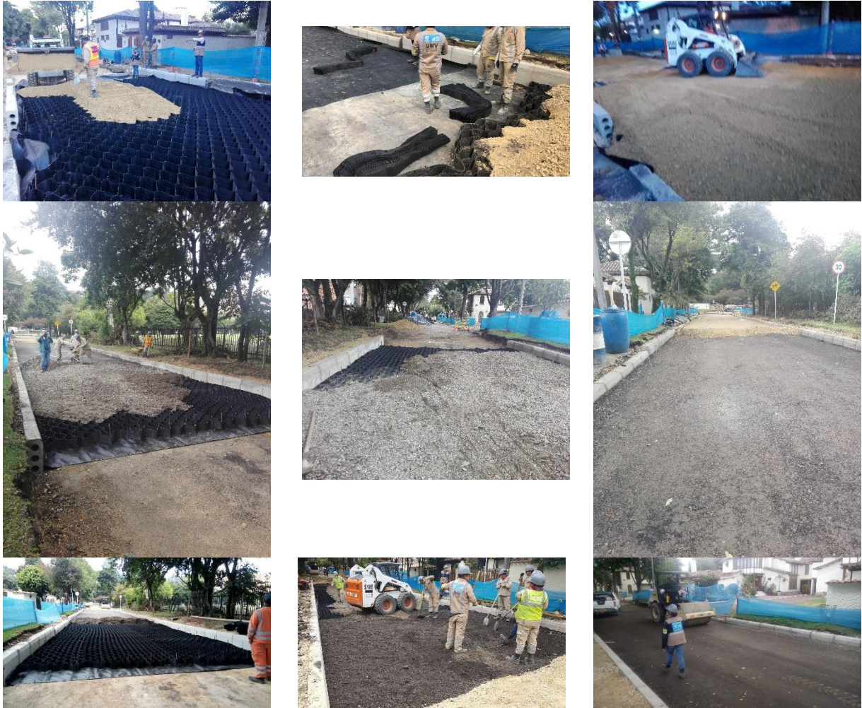
Ilustración 9 Fotografías llenado de las geoceldas con subbase granular y con fresado.
