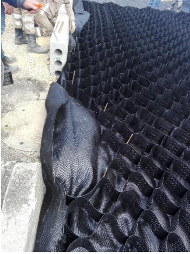
Ilustración 8 Fotografías instalación de geoceldas.
