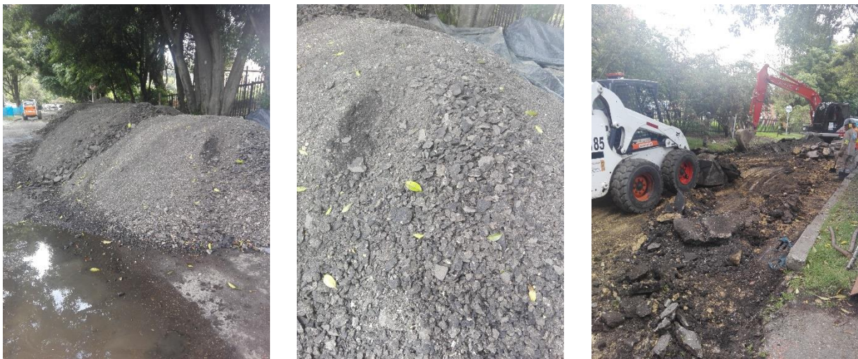
Ilustración 6 Fotografías inicio de excavación y fresado acopiado.
