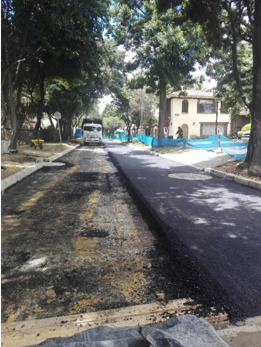
Ilustración 17 Fotorgrafías instalación de carpeta asfáltica.
