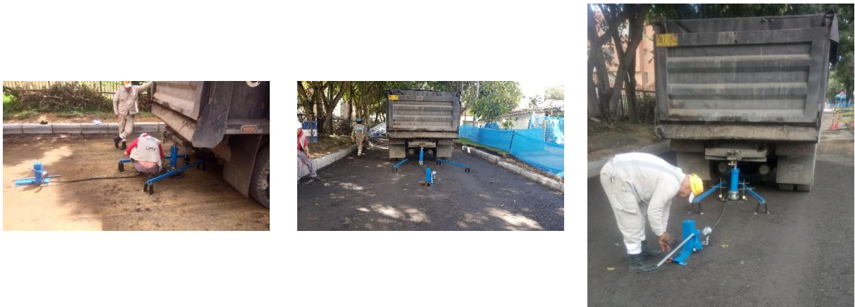
Ilustración 10 Fotografías ensayos de placa a los tramos de geoceldas con subbase granular y con fresado.
