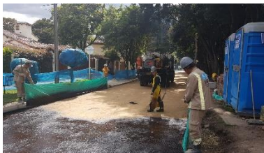
Ilustración 15 Fotografías imprimación de los tramos convencionales.
