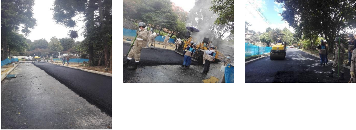
Ilustración 11 Fotografías instalación de carpeta asfáltica del tramo de las geoceldas con subbase granular y con fresado.
