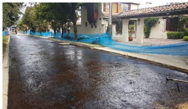
Ilustración 15 Fotografías imprimación de los tramos convencionales.
