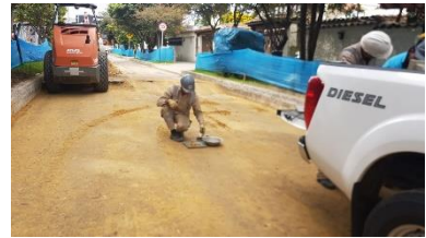
Ilustración 14 Fotografías inflación de base en los tramos convencionales, liberación de la capa.
