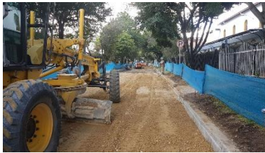
Ilustración 14 Fotografías inflación de base en los tramos convencionales, liberación de la capa.
