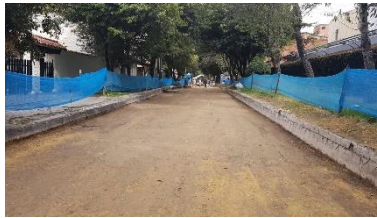
Ilustración 14 Fotografías inflación de base en los tramos convencionales, liberación de la capa.
