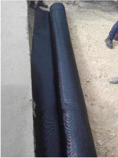
Ilustración 7 Fotografías instalación de geotextil fibrilado
