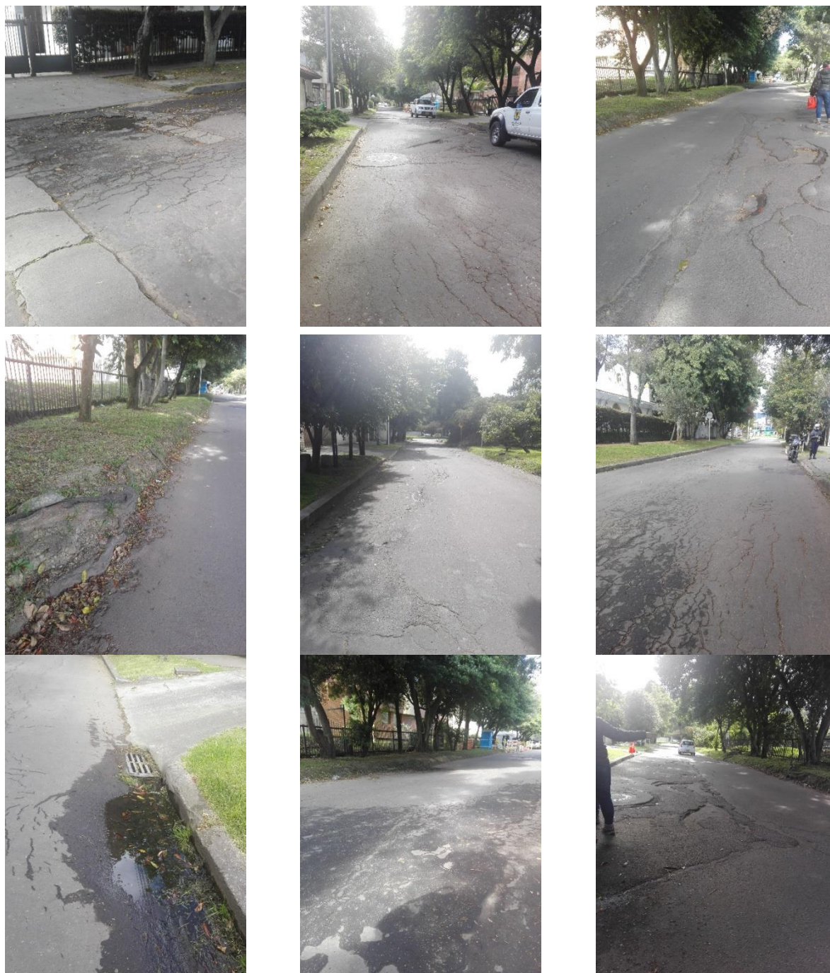
Ilustración 4 Fotografías del antes de la intervención
