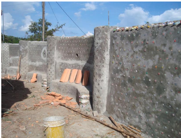
Figura 13. Construcción de muros con “Ecoladrillos”
