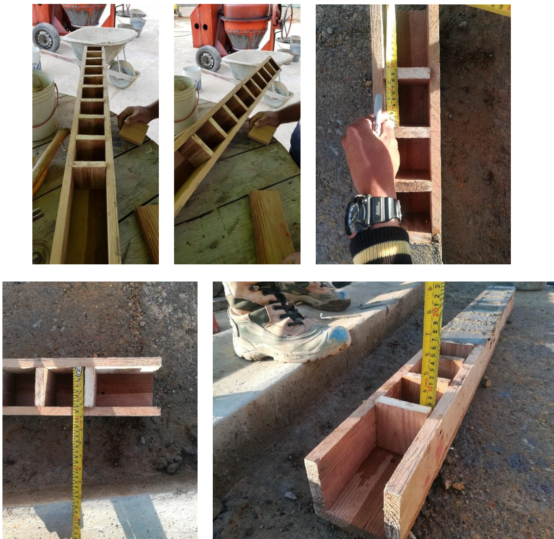
Figura 17. Fotografías Armado de formaleta y dimensiones
