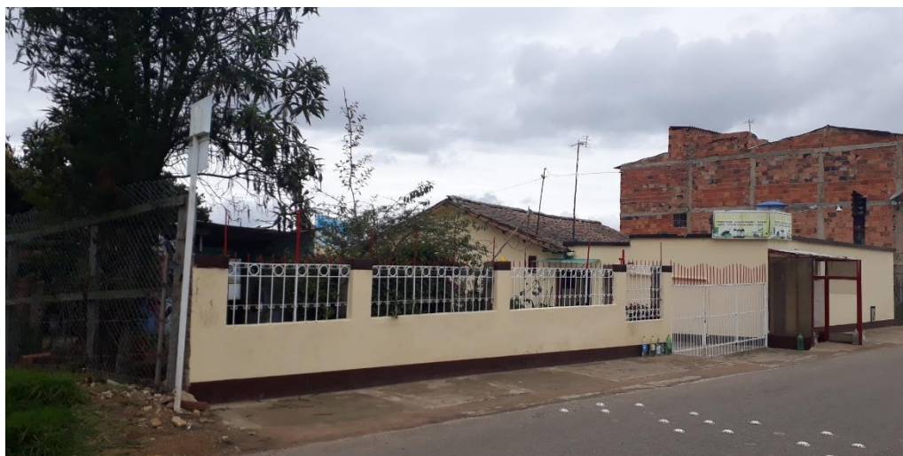
Figura 17. Vista frontal de la vivienda.
