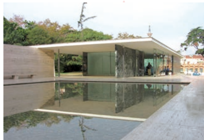
Fuente: Canaan (2008). Pabellón de Alemania en Barcelona (1928-1929), por Mies van der Rohe
