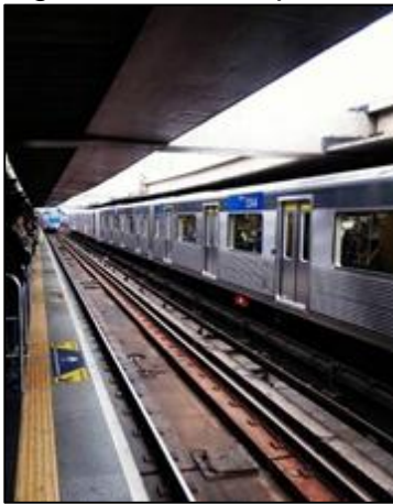
Figura 14. Vía Superficial del Metro
