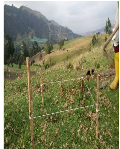
c) Localización de la caja de inspección.
