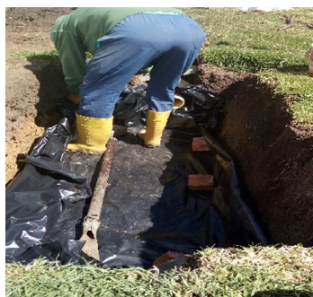
b) Instalación de la Geomembrana.
