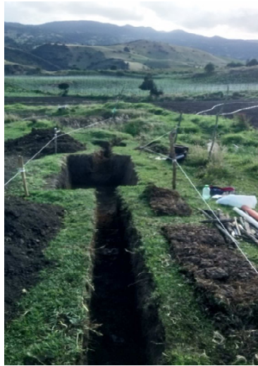
b) Excavación de cajas de inspección.
