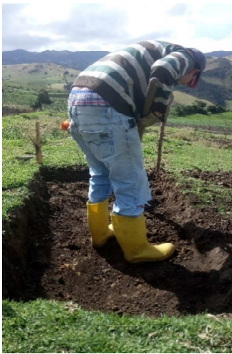
a) Excavación del humedal artificial.
