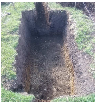
a) Compactación del suelo.
