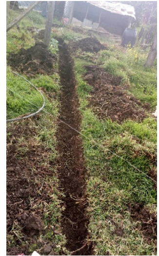
c) Excavación de la tubería.
