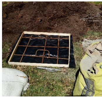
b) Refuerzo de la tapa de entrada.
