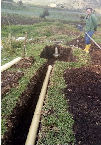
a) Instalación de la tubería de entrada y salida del humedal.
