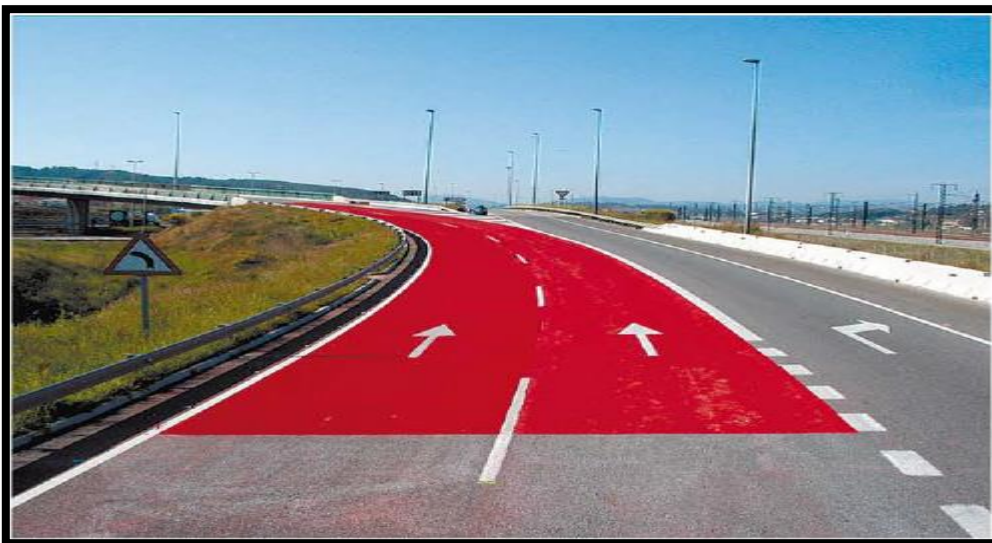
Figura 20. Aplicación de COLORVIAL en curva peligrosa en Barcelona.
