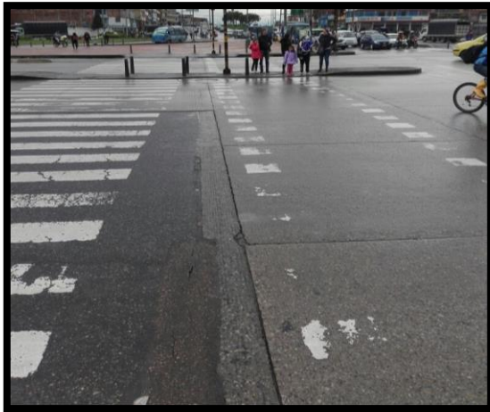
Figura 78. Superficie de rodadura tramo 1
