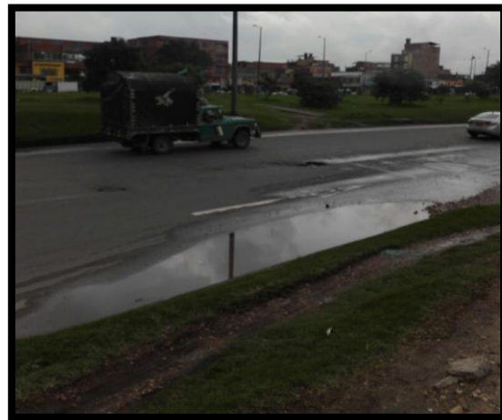
Figura 70. Superficie de rodadura tramo 3.1
