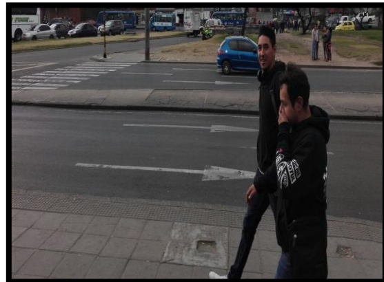
Figura 61. Superficie de rodadura tramo 2.1
