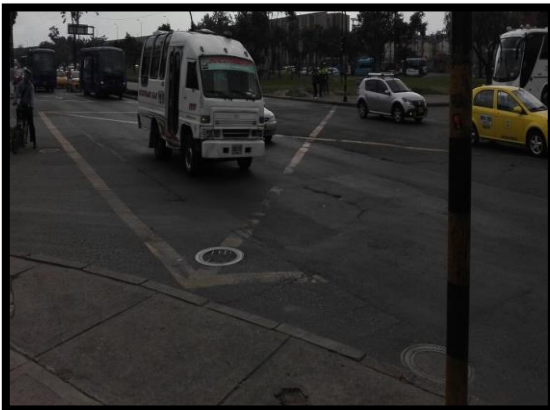
Figura 60. Superficie de rodadura tramo 2
