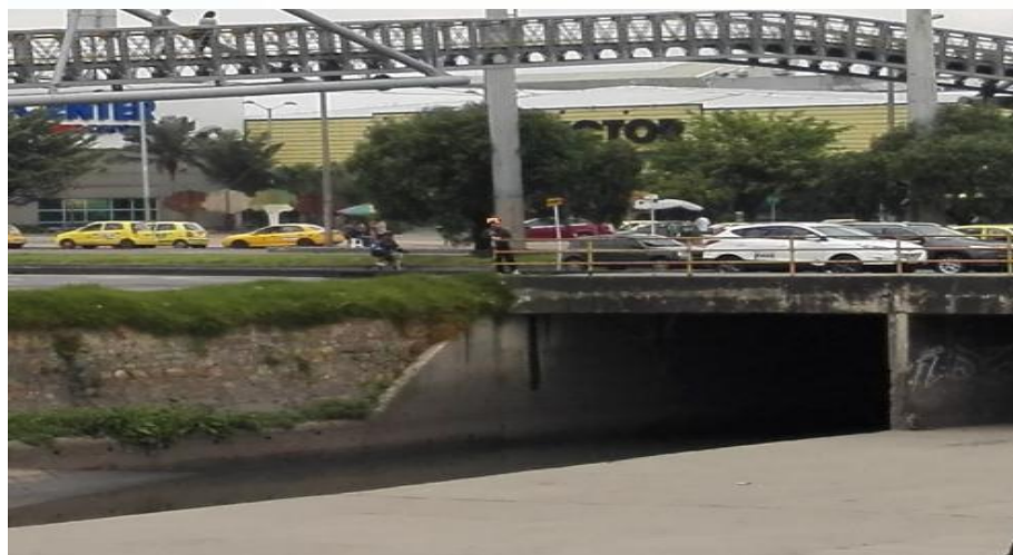
Ilustración 20. Topografía izquierda, estructura vial
