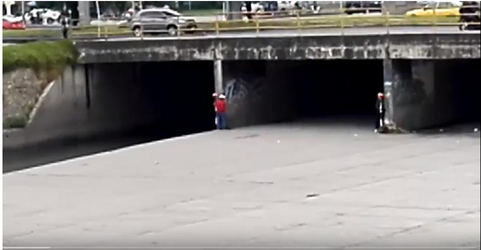
Ilustración 19. Sección Box Culver.
