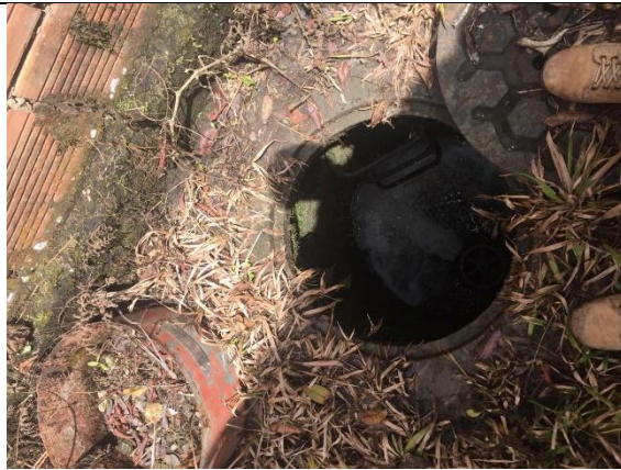
Ilustración 25. Fotografía de alcantarilla para lavado de tanque.
