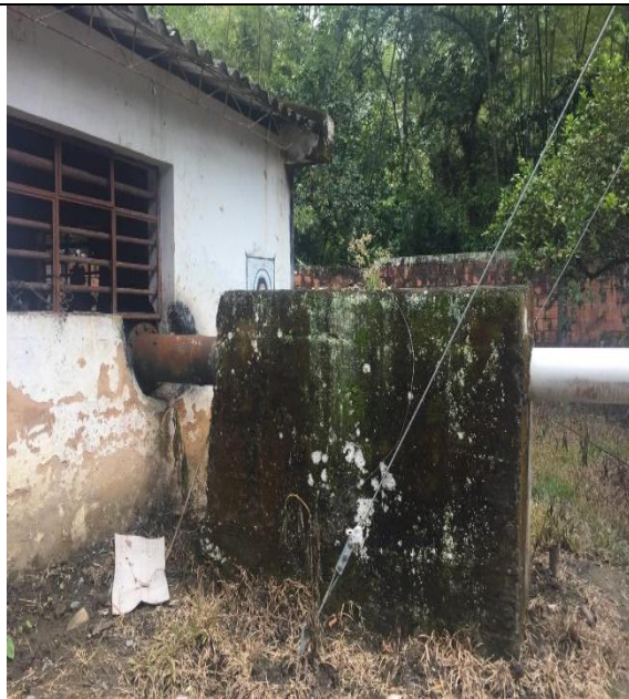
Ilustración 28. Fotografía muro de concreto que funciona como macho.
