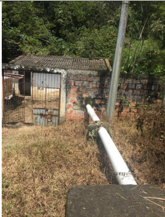
Ilustración 29. Fotografía de la tubería PVC 8 pulgadas.
