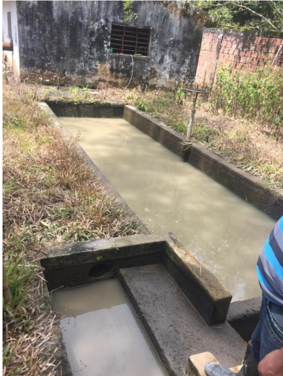
Ilustración 19. Fotografías de desarenador Punto de oro.
