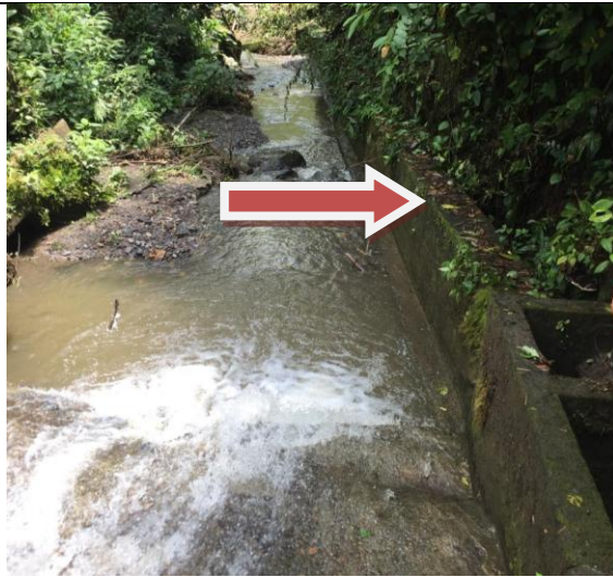
Ilustración 15. Fotografía de la tubería encofrada.
