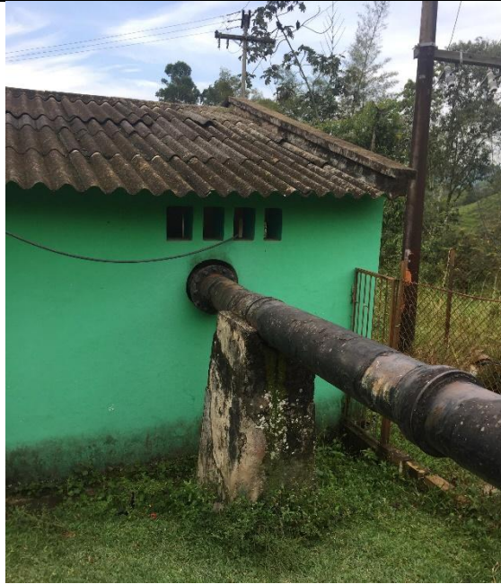
Ilustración 34. Fotografía Tubería de Acero conducción, Matadero - El alto.
