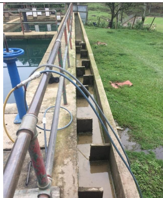
Ilustración 37. Fotografía PTAP Matadero, Tabiques.
