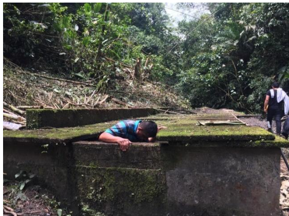
Ilustración 16. Fotografía de desarenador los Tiestos.
