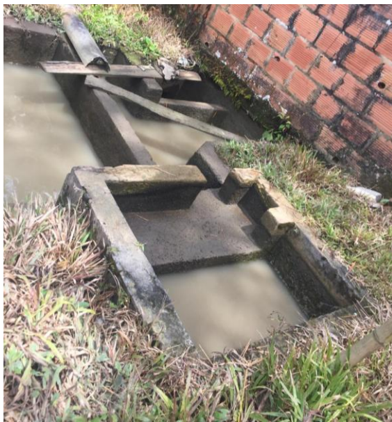
Ilustración 19. Fotografías de desarenador Punto de oro.
