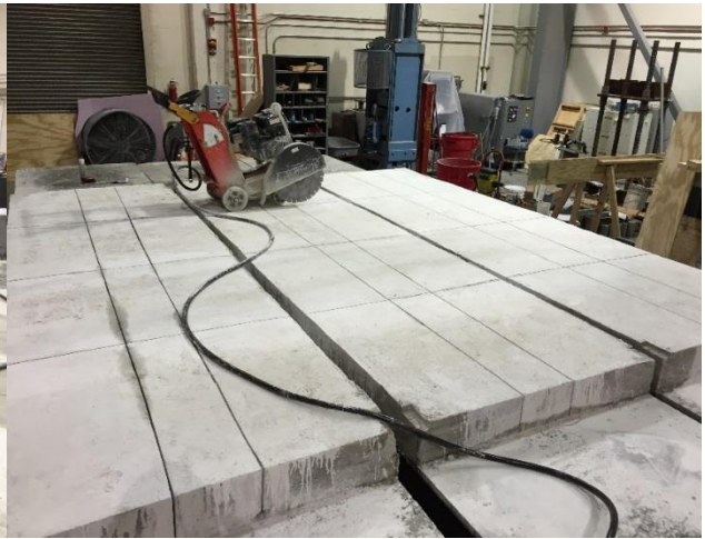
(d) Decks after Saw-Cutting
