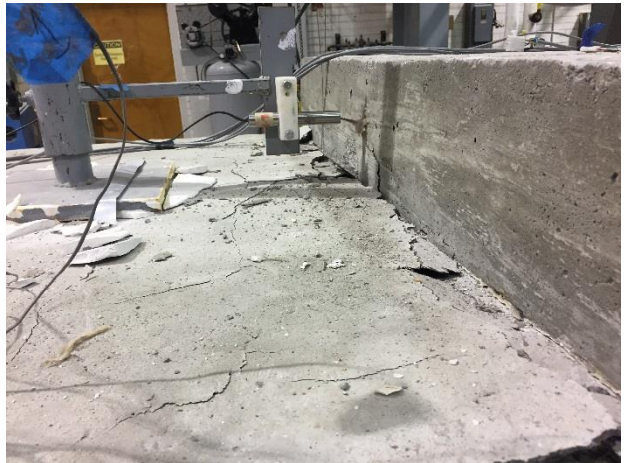
(d) Girder Top Flange Cracking after Failure
