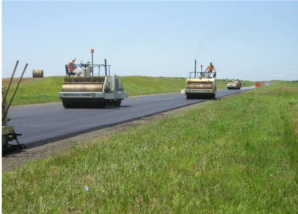
Fig. 27. Compaction
