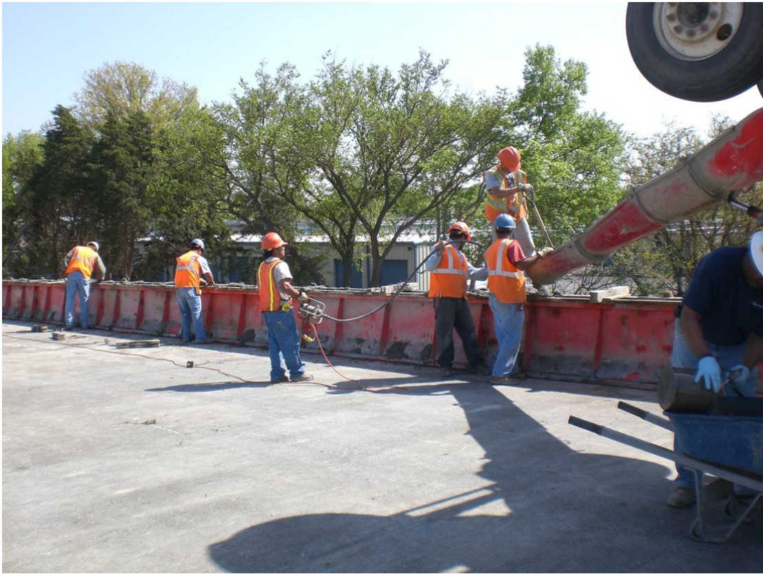
Barrier Rail Pouring
