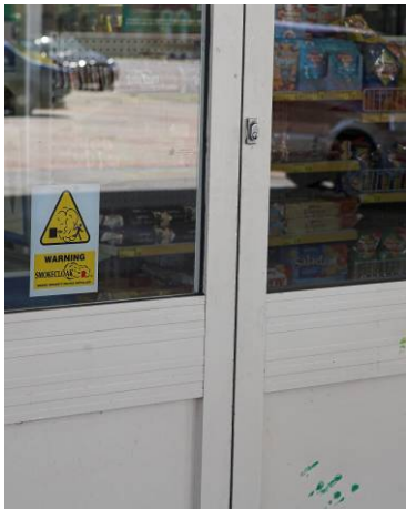
Fig. 4.5.3A – Signage on Front Door
