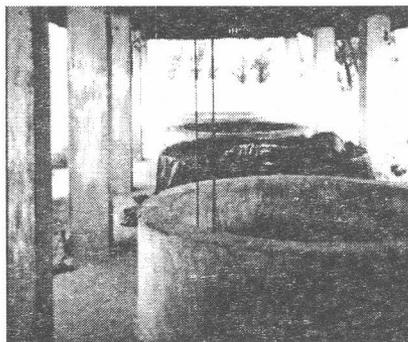
Figura 5 . silo tipo cisterna, descarregado manualmente. Fonte: DEMARCHI
