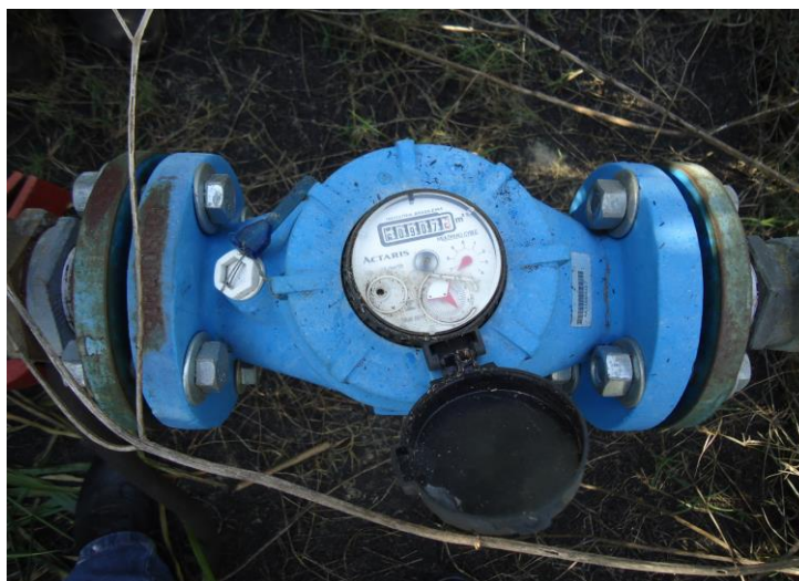
Figura 07: Foto hidrômetro poço artesiano da usina em estudo – Out.2010
