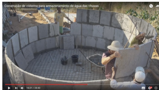
Figura 3: Construção de Cisterna para armazenamento de água das chuvas Fonte: https://www.youtube.com/watch?v=IBvbf9bNXcl
