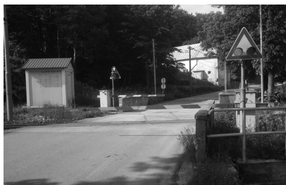
Slika 2. Željezničko-cestovni prijelaz Zlobin
