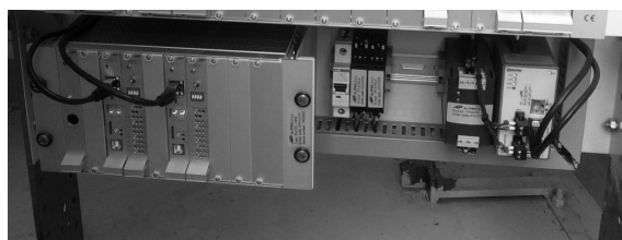
Slika 9. Mikroprocesorska platforma APIS DK za sučelje s APB-om i komunikaciju prema uređaju ŽCP-a Figure 9. Microprocessor platform APIS DK for interface with AB and communication with level crossing
