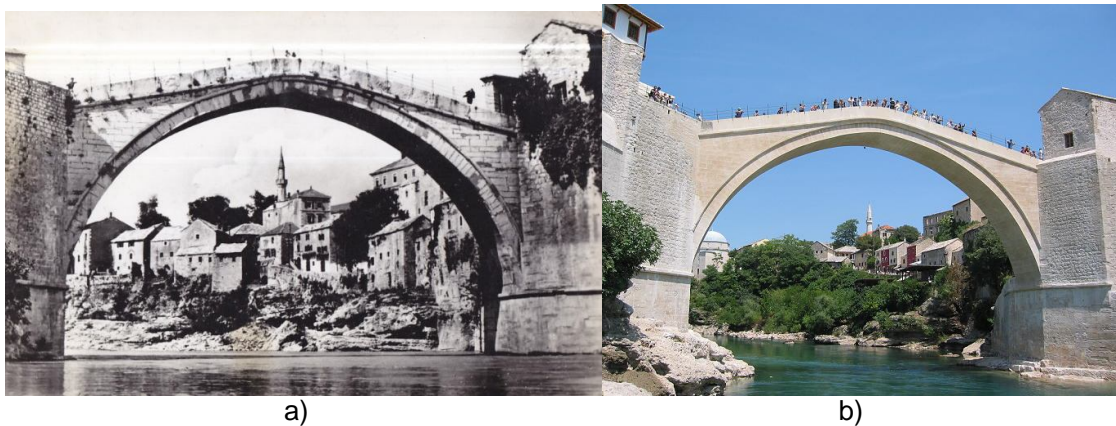
Slika 1. Stari most i rekonstruirani "novi" Stari most
