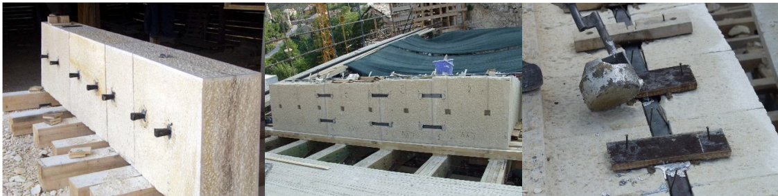
Slika 2. Detalji sklapanja svoda mosta
