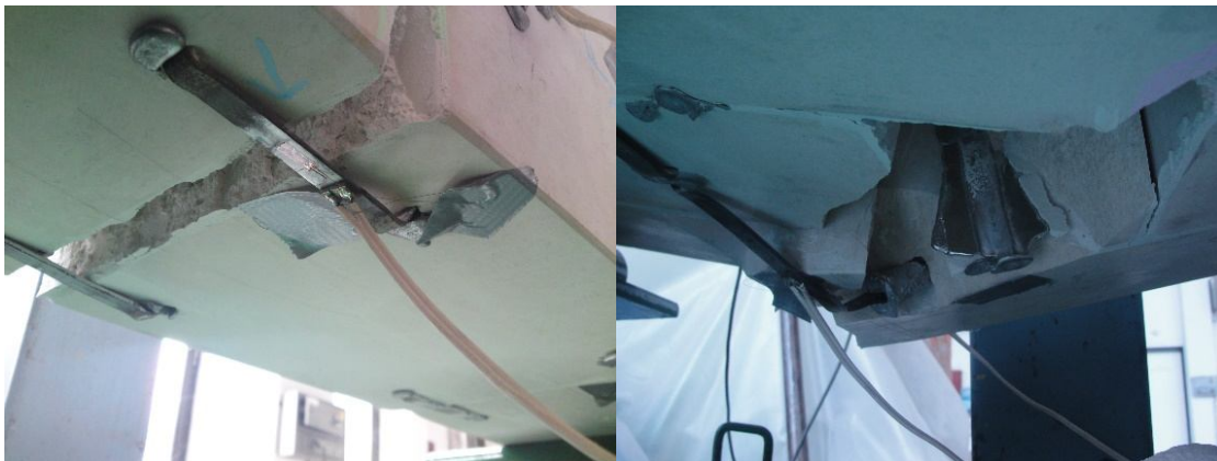
Slika 10. Izvlačenje klanfi i trnova iz ležišta
