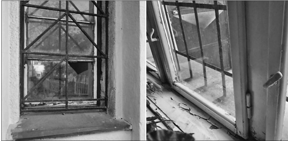
SL. 4. VANJSKI OTVORI, TRENUTAČNO STANJE FIG. 4 EXTERNAL OPENINGS, PRESENT CONDITION
