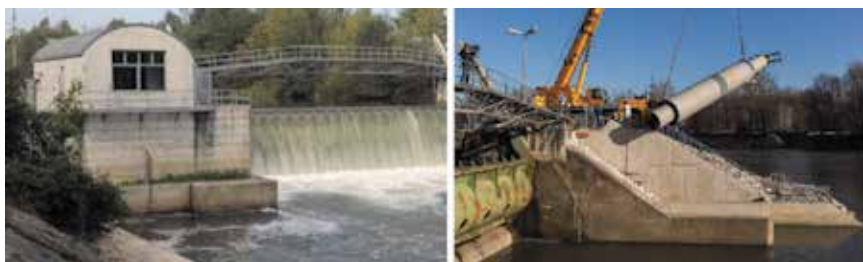
Slika 1. Pogled na branu Retznei s prvobitnom hidroelektričnom centralom (lijeva fotografija) i na novu hidroelektranu s cjevastim dvojnim rotirajućim pužnim pogonom na lijevoj obali (desna fotografija)
