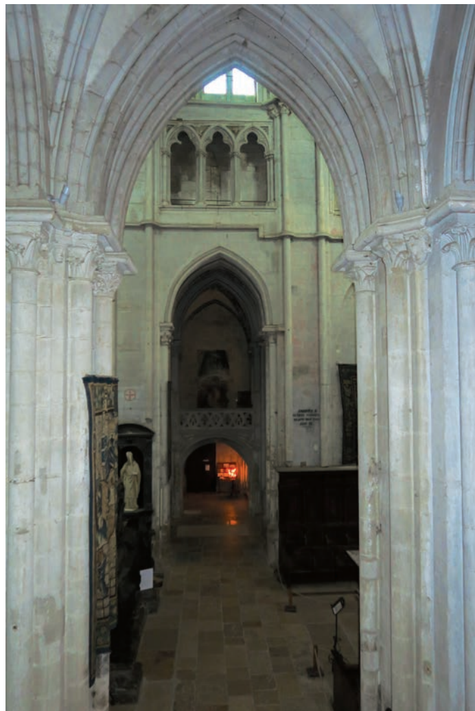
Fig. 2. Saint-Antoine-en-Viennois, abbatale: vue du bras nord du transept, depuis le bras sud. Cliché de l'auteur.
