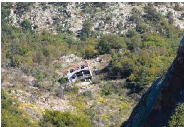
Slika 3: Stručna ekskurzija, klizište Markovići, Kotor, Crna Gora (19. listopada, 2017.)
