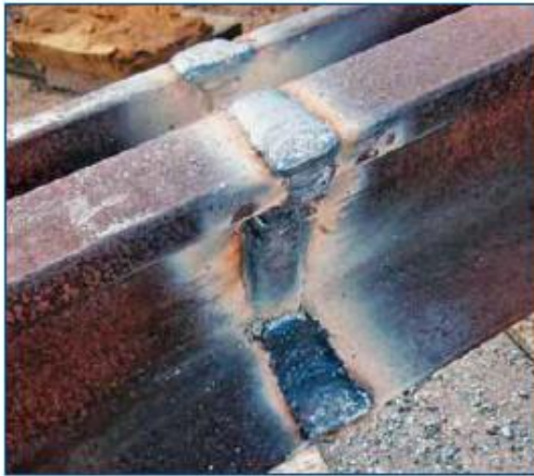
Slika 8. Konačni izgled zavara tračnice prije brušenja Figure 8. Finished weld before grinding
