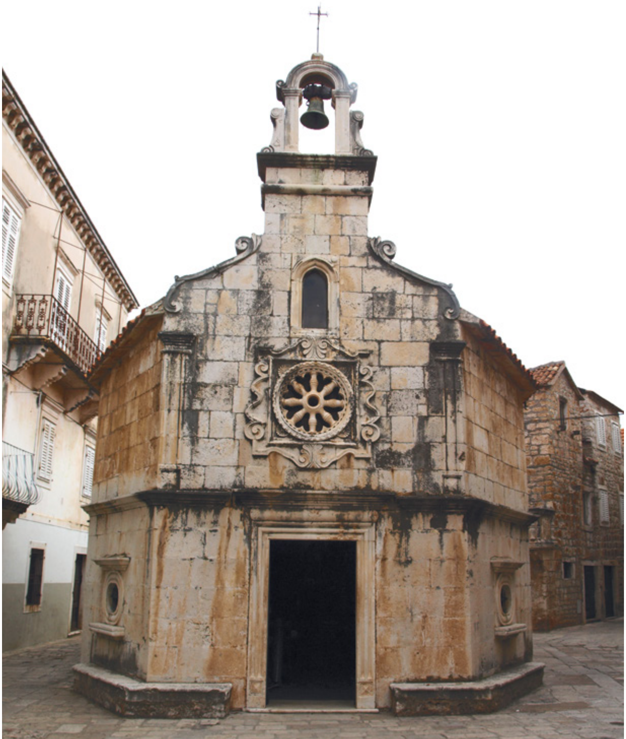
1. Zapadno pročelje crkve sv. Ivana u Jelsi prije zaštitnih radova (snimila I. Letilović, 2011.) West front of St. John's Church in Jelsa, before protection works (photo by I. Letilović, 2011)
