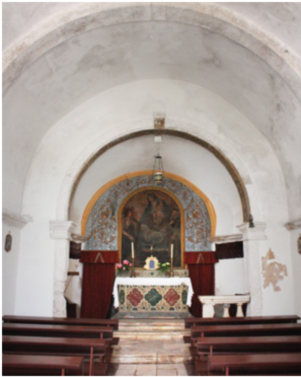
5. Unutrašnjost crkve prije zaštitnih radova (snimila A. Gamulin, 2011.) Interior of the church, before protection works (photo by A. Gamulin, 2011)
