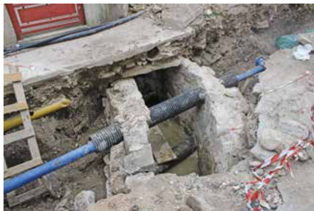
15 Nove cijevi kanalizacije i vodovoda provedene kroz strukturu kanala koja je vraćena u zatečeno stanje (foto: I. Pleština, fototeka Konzervatorskog odjela u Trogiru, 2016.)
