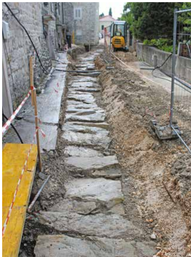
9 Kanal s poklopnicama datiran u 19. stoljeće (foto: I. Pleština, fototeka Konzervatorskog odjela u Trogiru, 2016.)
