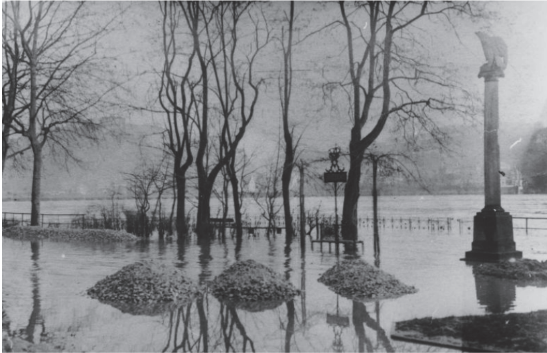
Figure 2. City of Koblenz, Germany, 12 March 1876 (from Stadtarchiv Koblenz, https://www.koblenz.de/stadtleben_kultur/stadtarchiv_eisenbahnsaeule_hochwassersaeule.html ).
