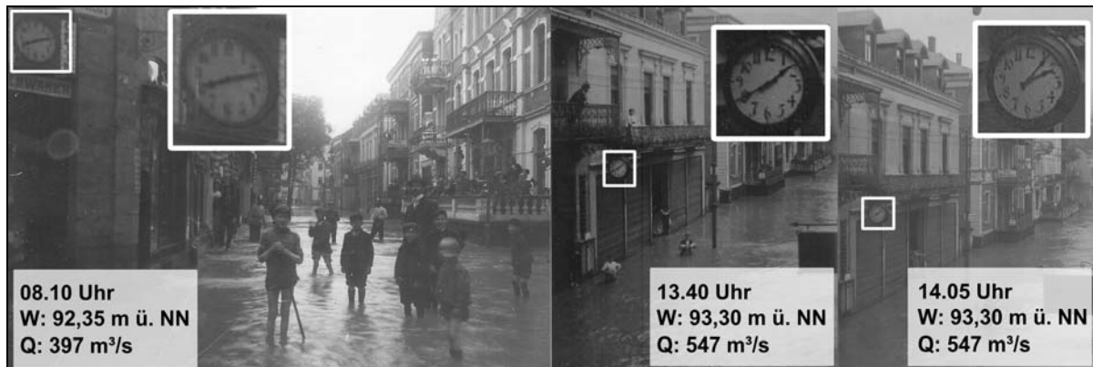
Abb. 3: Historische Photographien mit Uhrzeitangaben zu den jeweiligen Wasserständen und die daraus rekonstruierten Abflusshöhen (Eigene Darstellung).
