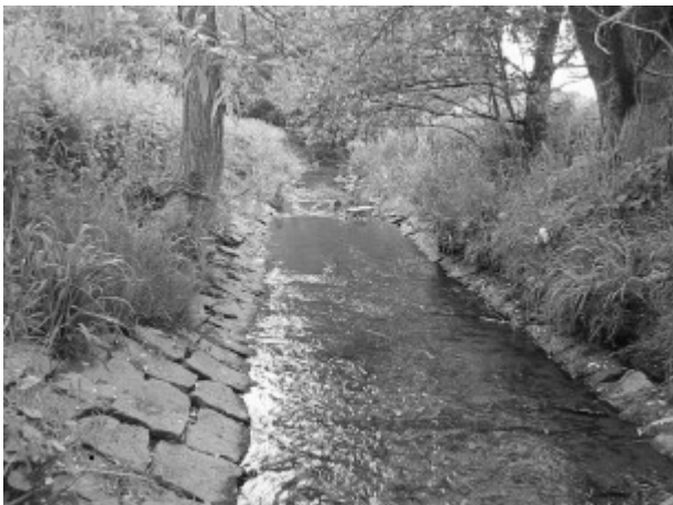
Abb. 1: Geradlinige Führung des Gewässers im Regelprofil vor der Renaturierung. Quelle: Aufnahme H. Diehl
