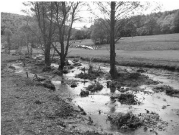
Abb. 1: Geradlinige Führung des Gewässers im Regelprofil vor der Renaturierung. Quelle: Aufnahme H. Diehl
