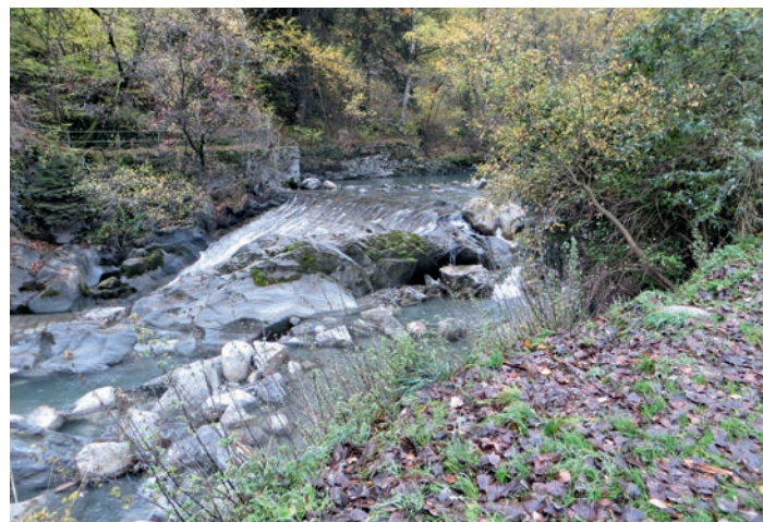
Figure 6: Seuil de la Meunière [km 5.100]. | Bild 6: Schwelle von la Meunière [km 5.100].
