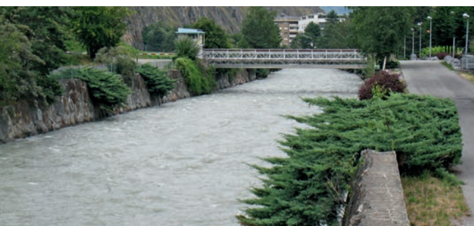
Figure 4: Digue moellonnée dans la traversée de ville. | Bild 4: aufgeschütteter Deich durch die Stadt.
