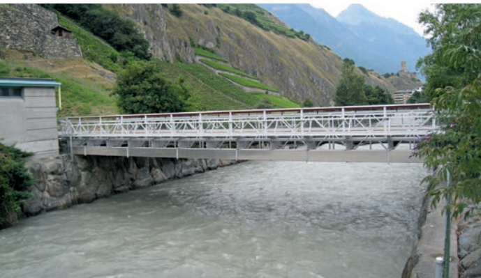
Figure 8: Pont du Rossetan [km 3.394]. | Bild 8: Brücke von Rossetan [km 3.394].
