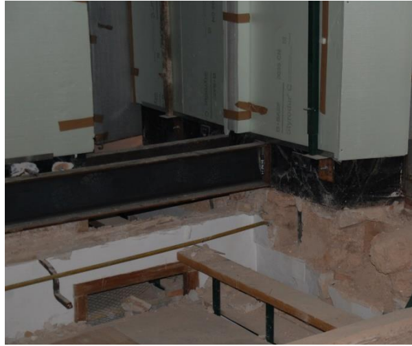
IMATGE 189: Detall dels perfils de ferro per subjectar els envans dels forjats substituïts.
