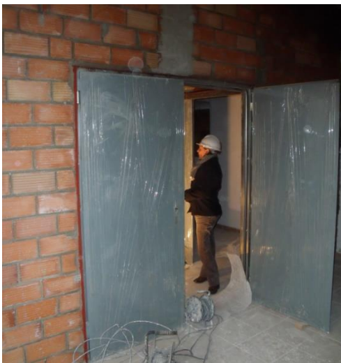
IMATGE 194: Procés d'instal·lació de les portes tallafocs.
