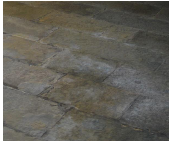
IMATGE 66: Detall del paviment d'enllosat de pedra.
