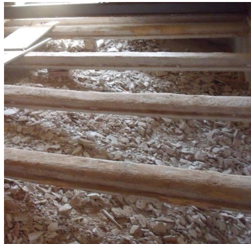
IMATGE 56: Detall de les bigues amb rebaix o sagnia, del terra del dormitori Imperi, durant les obres de rehabilitació del 2010.
