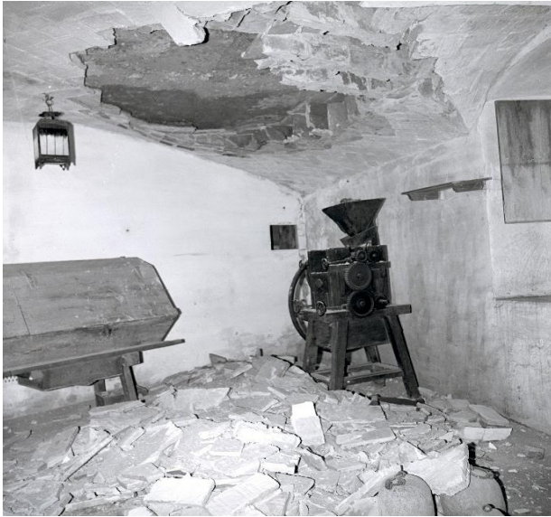
IMATGE 141: Imatge de l'estat del graner després de l'esfondrament del sostre, l'any 1979.
