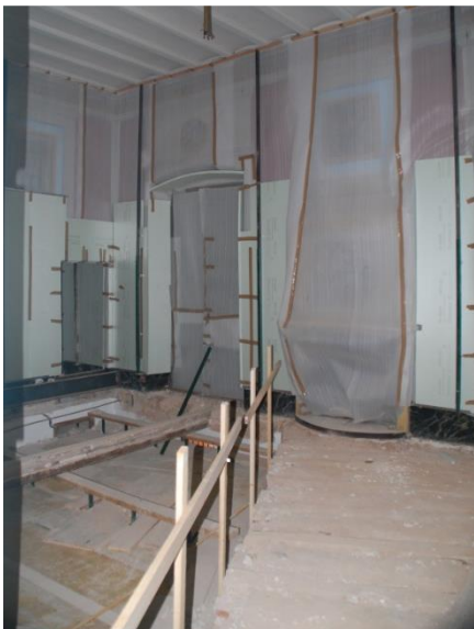
IMATGE 190: Procés de substitució del forjat del del menjador, el qual queda afectat per dos embigats diferents.
