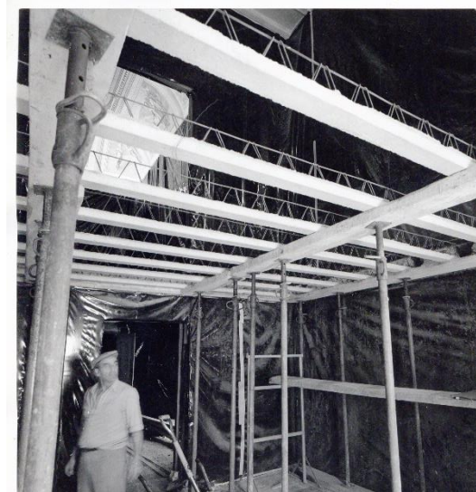
IMATGES 146 I 147: Imatges del procés de substitució del forjat de l'entresòl, el 1982.
