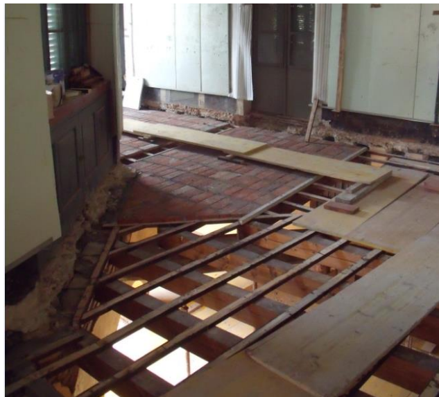
IMATGE 191: Procés de construcció del nou forjat de la galeria.
