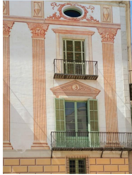
IMATGE 8: Fotografia de detall dels elements pictòrics de la façana del carrer Major.
