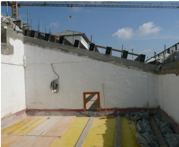
IMATGE 177: Procés de desmuntatge de la coberta original.
