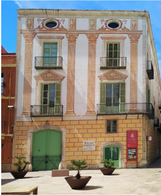
IMATGE 7: Fotografia de l'estat actual de la façana del carrer Major.
