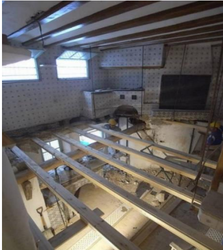
IMATGE 188: Procés de substitució del forjat del terra de la cuina.
