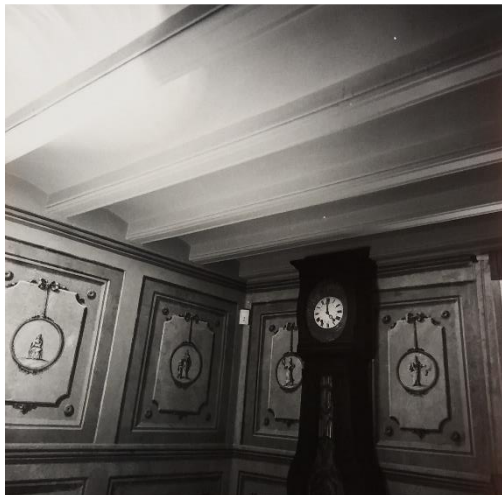
IMATGE 148: Imatge del nou forjat del sostre de la biblioteca, després de la substitució.
