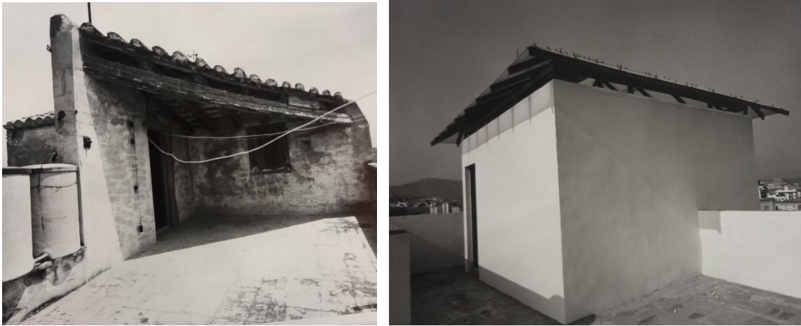
IMATGES 161 I 162: Imatges de l'acabament de la caixa d'escala (accés a les cobertes), abans i després de la intervenció.
