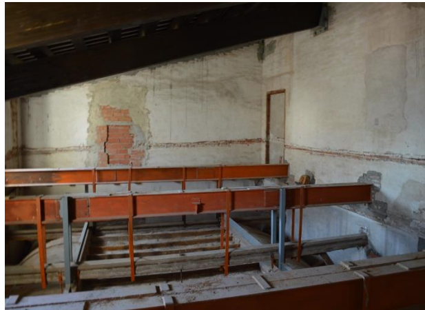
IMATGE 180: Estat actual dels suports de la volta de la Sala de Ball, després de la intervenció.
