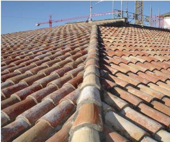
IMATGE 179: Resultat final de la teulada després de la substitució.
