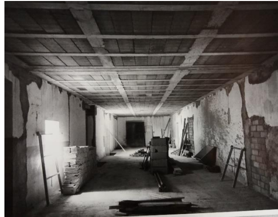
IMATGE 158: Vista del forjat després de ser substituït (imatge presa des del 2n pis).
