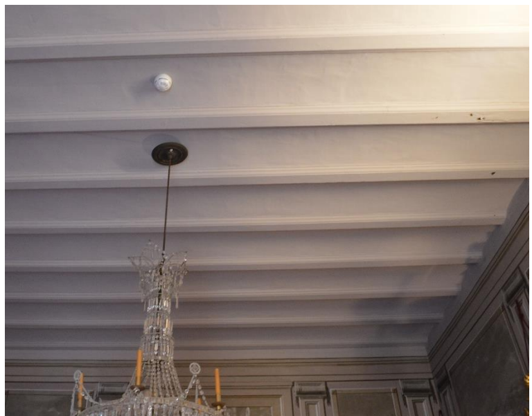
IMATGE 58: Detall del sostre de bigues de fusta de la planta principal, en el seu estat actual.
