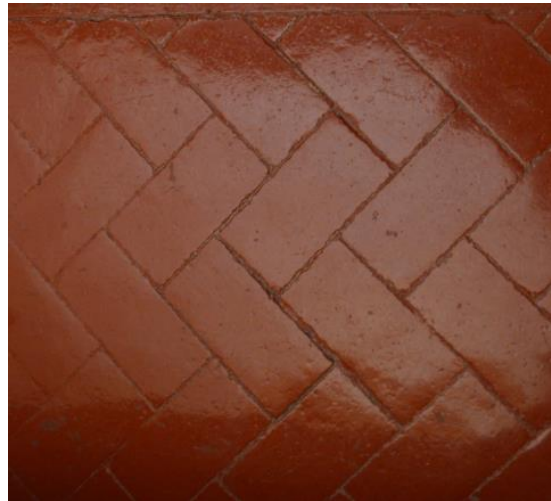
IMATGE 64: Detall del paviment de rajola vermella amb una capa de protecció.
