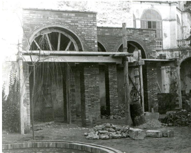
IMATGE 122: Procés de construcció de la galeria nova durant els darrers mesos del 1961.
