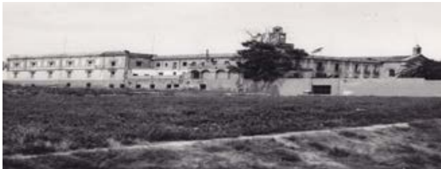
Figura 6. Vista de la antigua cárcel de mujeres de Les Corts tomada desde la actual avenida Carlos III. Fuente: Arxiu Municipal del Districte de Les Corts.
