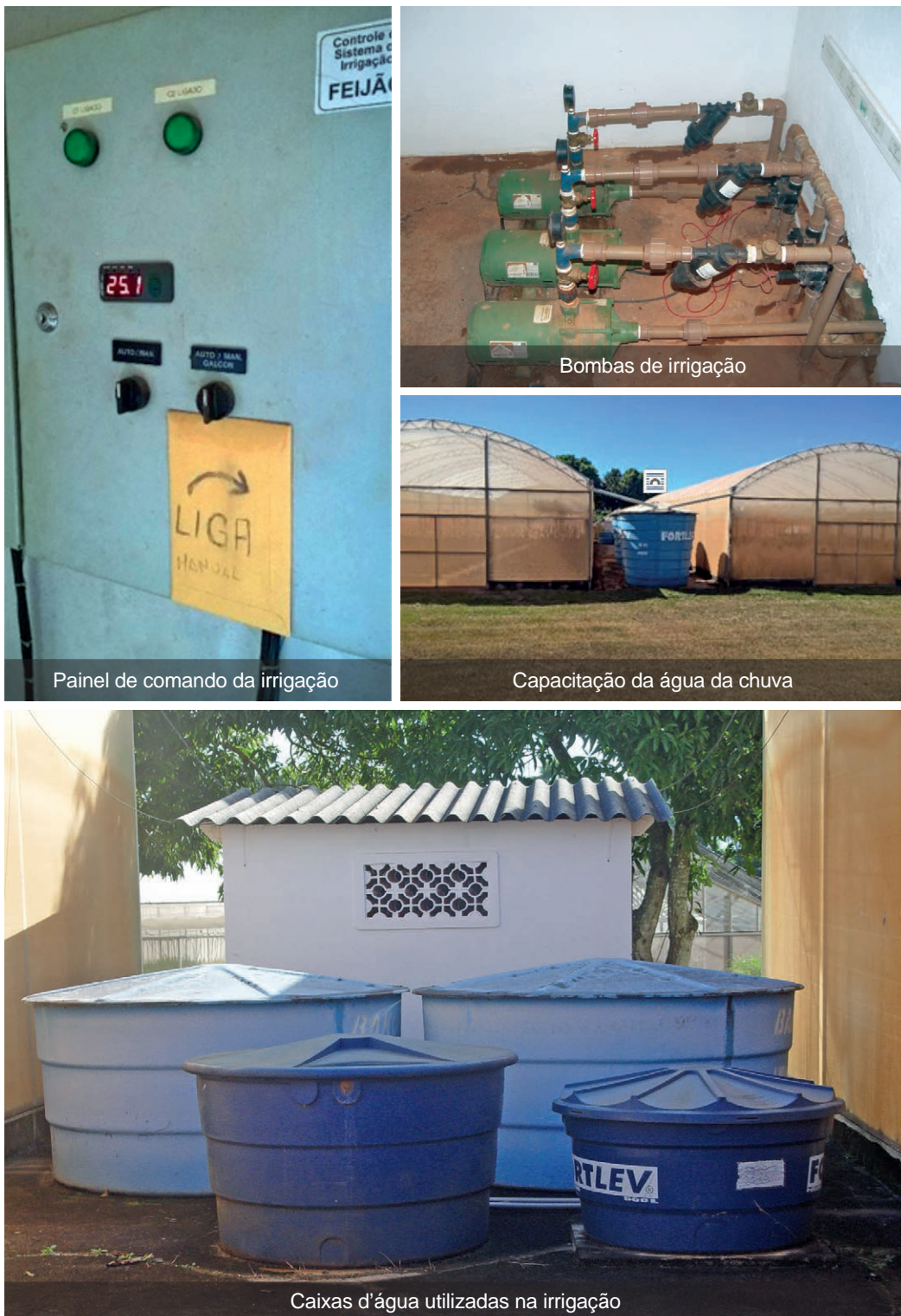
Figura 7. Sistema de irrigação automatizado do BAG Arroz e Feijão e captação de água das chuvas, utilizada na época da seca.
