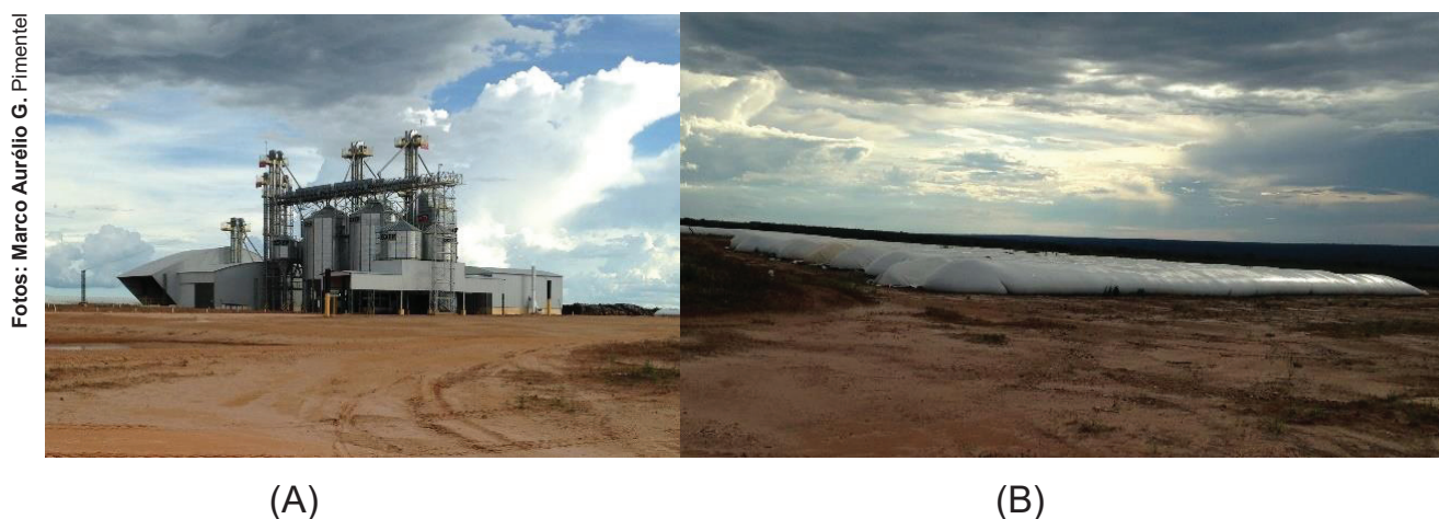
Figura 49. Sistemas de armazenamento de grãos com silos metálicos e estrutura de pré-processamento dos grãos (A) e sistema temporário de armazenagem com uso de silo bolsa (B) nas propriedades rurais no Circuito Cocos-Jaborandi, sul do Matopiba, março 2018.
