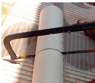
Figura 109. Cano de PVC de 100mm sendo cortado na medida recomendada.
