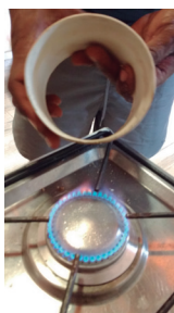
Figura 110. Extremidade do cano sendo aquecida para o seu alargamento.
