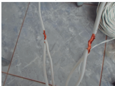
Figura 51. Junção dos pedaços menores as "pernas" maiores.
