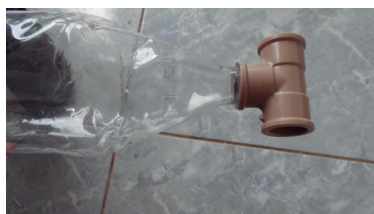
Figura 99. Encaixe da garrafa ao T de 25mm.
