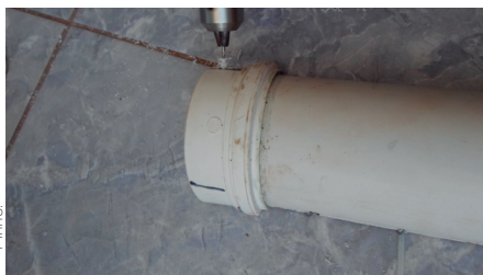
Figura 62. Caps sendo afixado ao cano.
