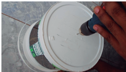
Figura 79. Balde sendo perfurado por furadeira, no fundo, ao centro.
