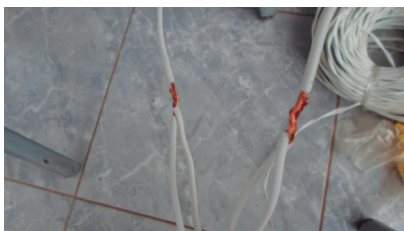
Figura 34. Pedacos de fio Interligados ao pedaço maior.
