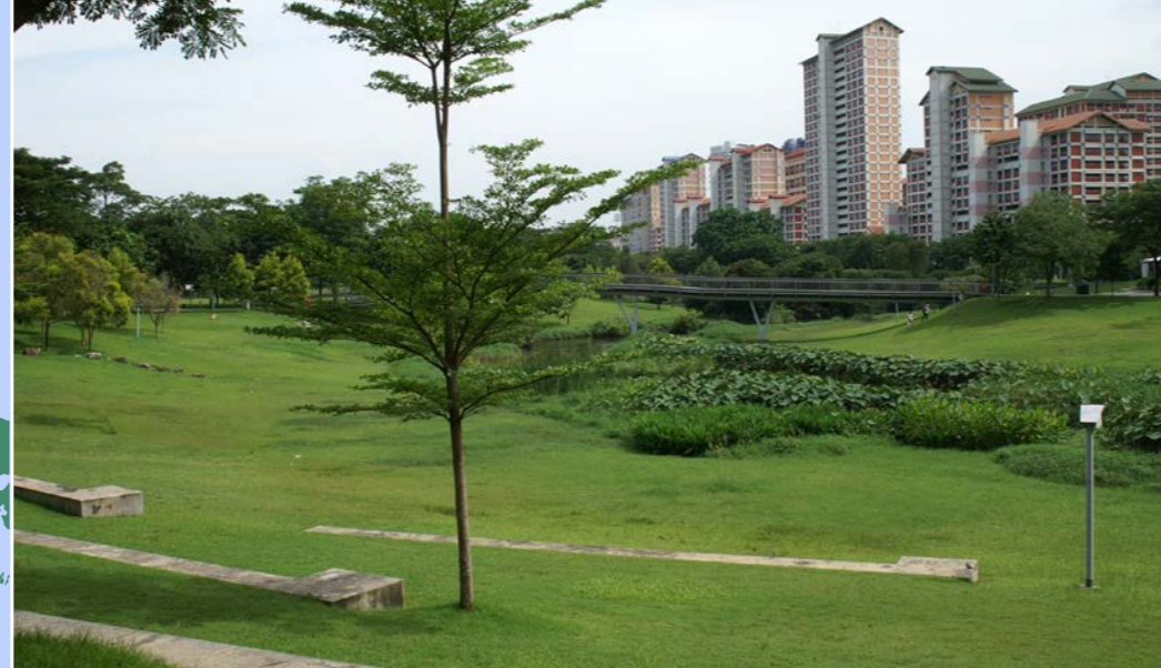
FIGUR 16. DET BEHÖVS STOR MARKYTA FÖR ATT TA UPP LIKVÄRDIGA MÄNGDER VATTEN SOM TIDIGARE TRANSPORTERADES I DEN HÄRDGJORDA KANALEN. BISHAN-ANG MO KIO PARK, SINGAPORE.
