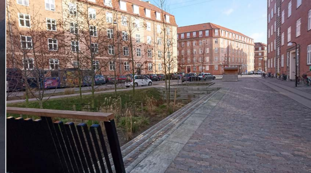
FIGUR 25. NEDSÄNKNING FÖR VATTENMAGASINERING, TÅSINGE PLADS, KÖPENHAMN.
