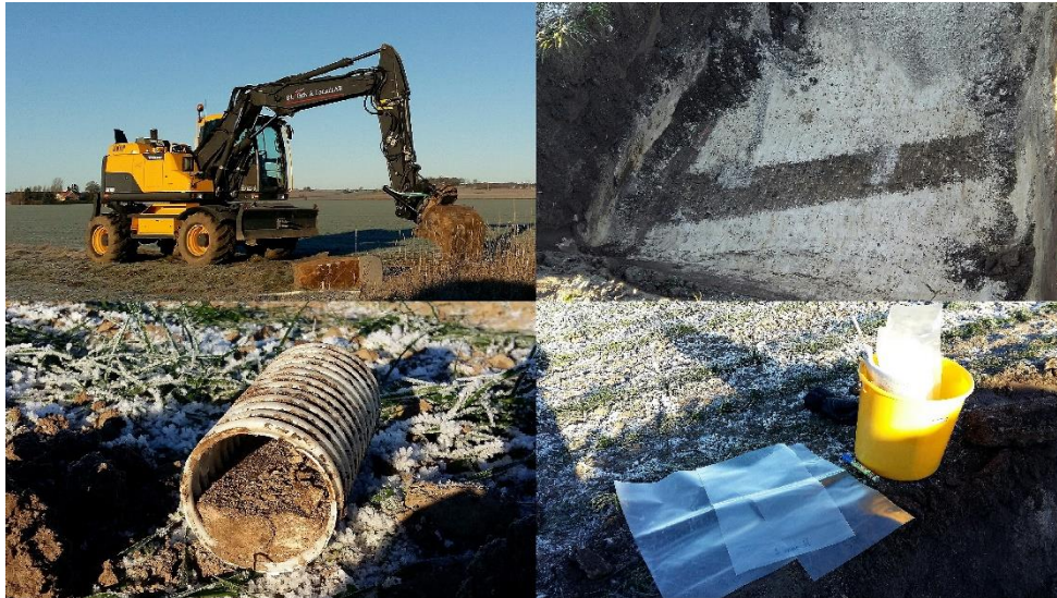
Figur 4. Framgrävning av dräneringsledningarna och insamling av jordprover från filterförsöket vid Härna. På fotot högst upp till höger syns en av de tio groparna som grävdes. Jorden var betydligt mörkare intill dräneringsledningen vilket troligen beror på att ledningarna täckts med matjord vid igenläggning. Foto: Hanna Falk
