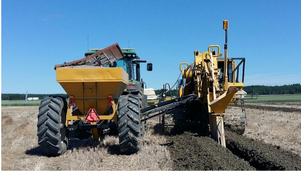
Figur 2. Placering av dräneringsgrus ovanpå dräneringsledningen vid täckdikning. Foto: Hanna Falk
