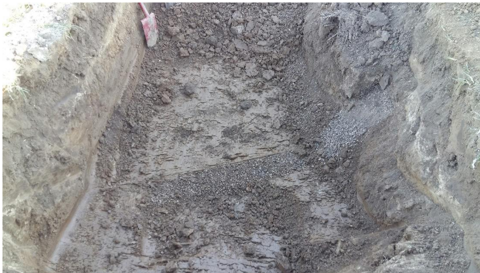
Figur 1. En framgrävd dräneringsledning med ett grusfilter. Foto: Hanna Falk
