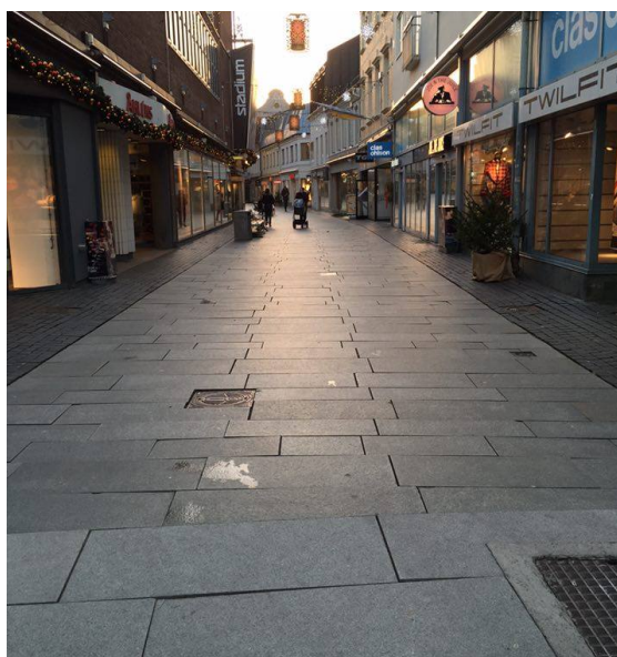
Bild 10 Av: Julia Rehnström Kullagatan. Här har mönstret anpassats till vattenavrinningen och därmed bomberingen.
