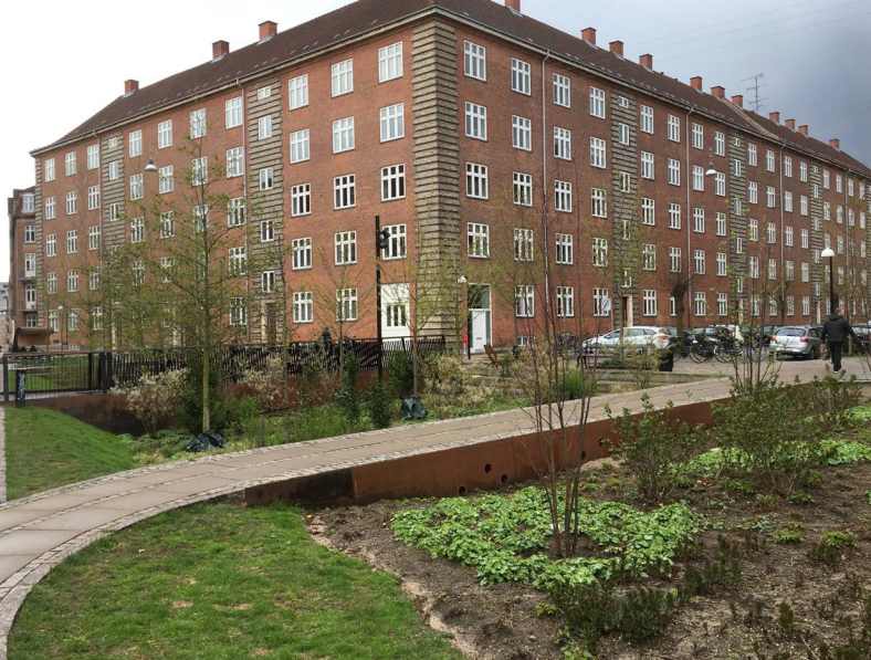
Figur 26. Utsikt över Tåsinge plads “Regnskoven” som ska lagra vattnet.
