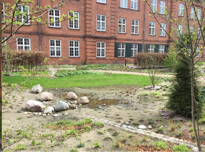
Figur 6. Nedsänkning som tar emot vatten från taket på ett av bostadshusen i De gamles by.
