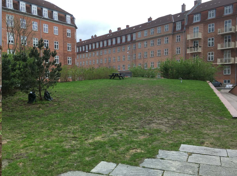
Figur 27. Tåsinge Plads högpunkt, “Solskrænten” där regn infiltreras i mark. Vid skyfall rinner vattnet ner mot “Torvet” och “Regnskoven”.
