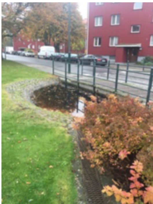
Figur 10: Damm under gångbro, Augustenborg i Malmö Foto taget: 2018-03-19
