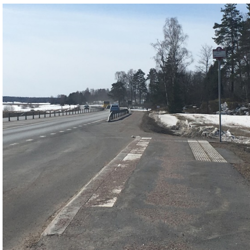
Figur 8. Hållplats Söderby i riktning mot Uppsala. Ett exempel på plattform på hållplats utan busskur. Bild: Emma Nilsson 2018-04-03.
