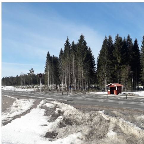
Figur 6. Hållplats Vettsta. Hållplats i riktning mot Uppsala har en busskur och den andra en stolpe. I mitten av vägen ses ett räcke vilket verkar som en barriär vid passage över vägen. Bilden är tagen från den gång- och cykelväg som leder rakt ut i bilvägen. Bild: Emma Nilsson 2018-04-03.
