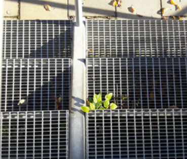
Gallerdurk i galvaniserat stål släpper igenom ljus och vatten.
