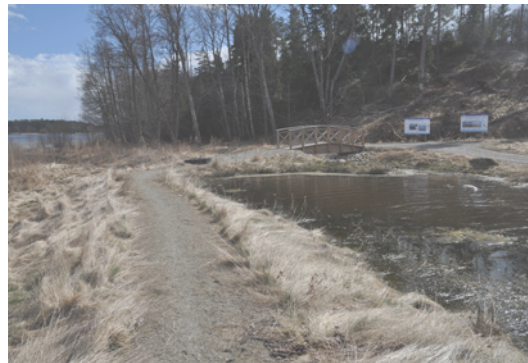
Gångbron över omlöpet och samlingsplatsen i bakgrunden.
