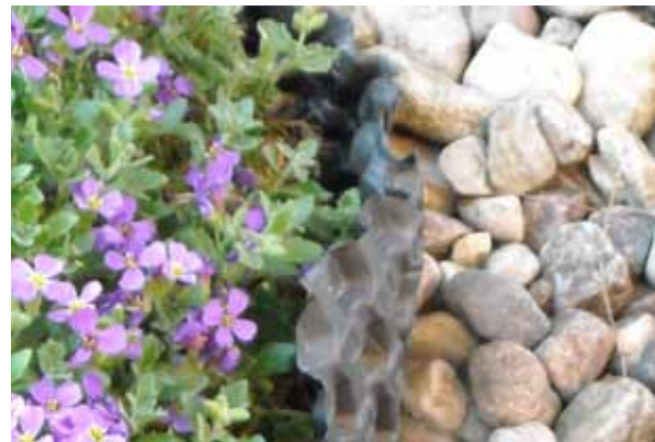
Fig 15. Dräneringslagret av expanderad cellplast skymtar fram
