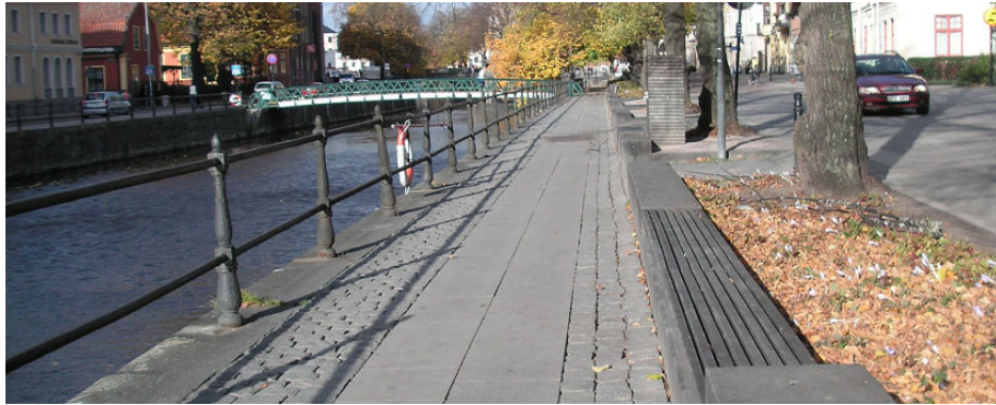
Stödmurens längd har platsens skala framför soffans.
