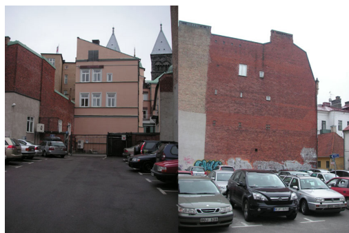
Till vänster; bevakad grind mot Sparbankshusets bakgård, till höger; den södra brandväggen.
