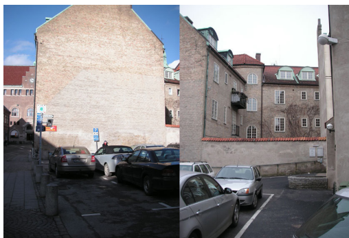
Till vänster; den norra brandväggen, till höger; den norra muren.
