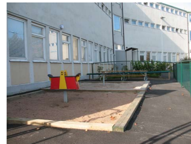
Ett typiskt exempel på en dåligt utformad förskolegård, detta exemplet är hämtat från en förskola inte långt ifrån Hakefjordgatans förskola.
