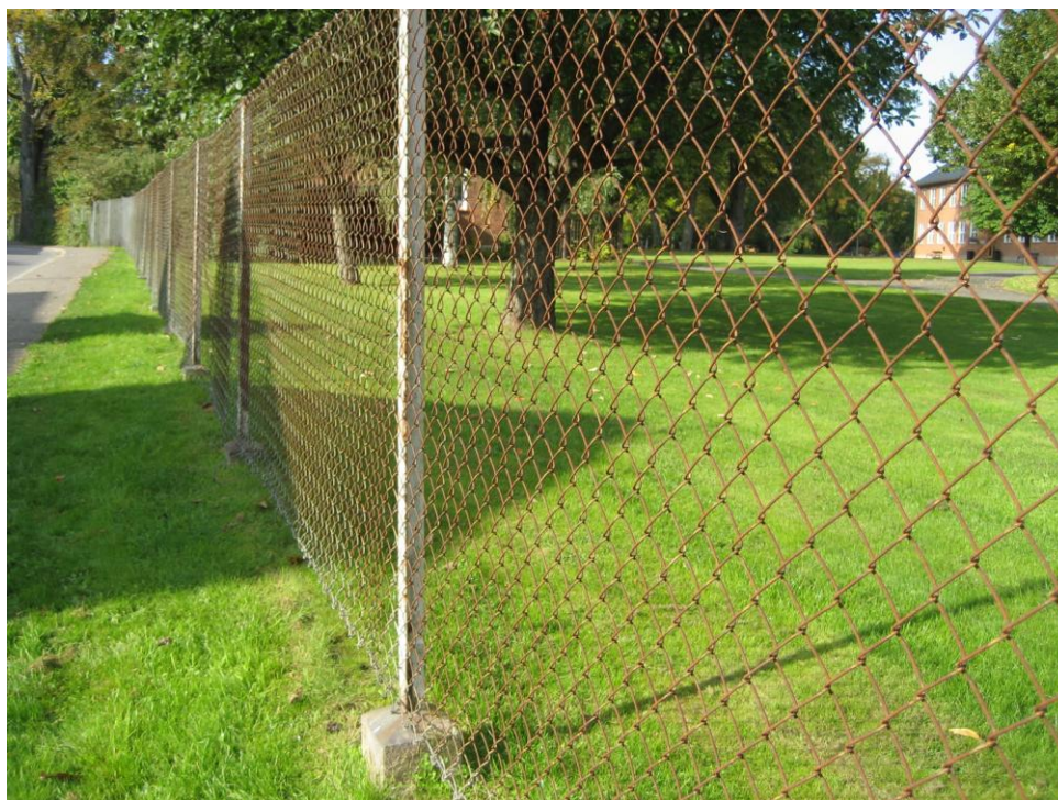
Figur 6. Staketet längs med områdets södra del. I bakgrunden till höger syns undervisningshuset.
