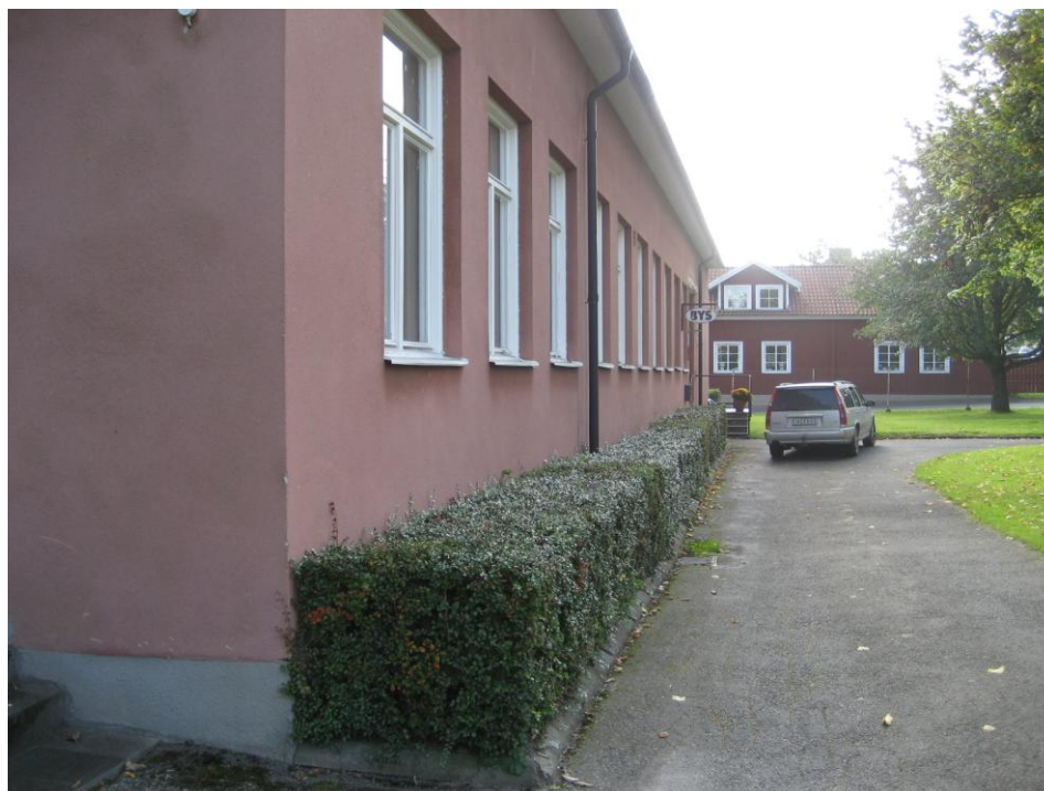
Figur 21. Välklippt hack längs med BYS byggnad.
